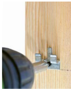
Fixieren sie den Anfangsclip an der markierten Position
