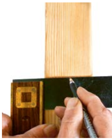
Markieren Sie die horizontale Position für den Anfangsclip
